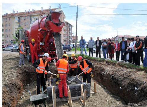
Polaganje kamena temeljca u Petra Arandjelovića 2012.
